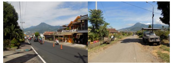
Gambar 7 Kondisi Jaringan Jalan di Desa Sidomulyo
