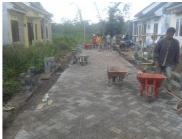
Gambar 5. Pekerjaan pemasangan paving
