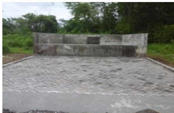
Gambar 10. Pelaksanaan dan hasil pekerjaan tempat pembuangan sampah
