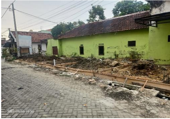
Gambar 7. Proses Pembangunan Pondasi Pada Lantai 1 yang Dilakukan oleh Warga Berdasarkan Acuan dari Gambar Perencanaan
