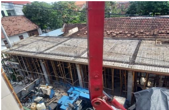
Gambar 8. Proses Pengecoran Lantai Ke 2, Yang Berdasarkan Gambar Perencanaan
