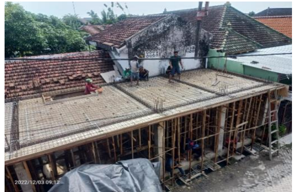
Gambar 8. Proses Pengecoran Lantai Ke 2, Yang Berdasarkan Gambar Perencanaan
